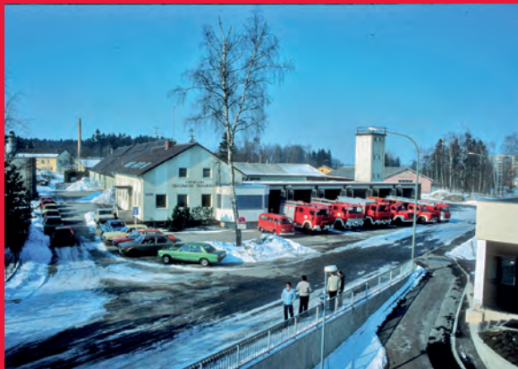
1981 Gerätehaus Banater Straße mit Funkzentrale 1963
